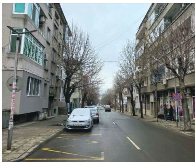
Новото осветление на ул. „Станционна“ в Айтос
