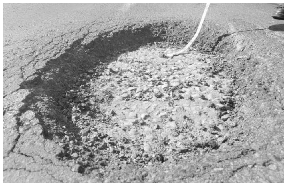
Най-голямата измерена дупка е с дължина 5 метра, широчина 2 метра и дълбочина 10 см
