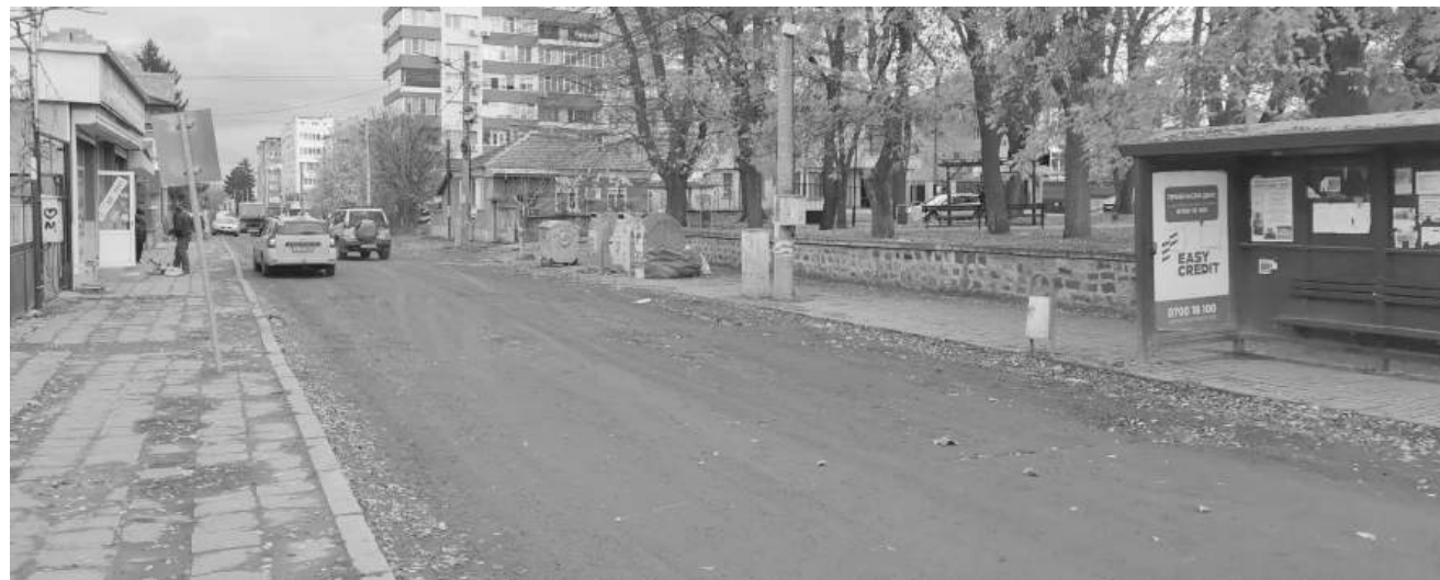
Започна основният ремонт на част от ул. „Св. св. Кирил и Методий“ в Карнобат
