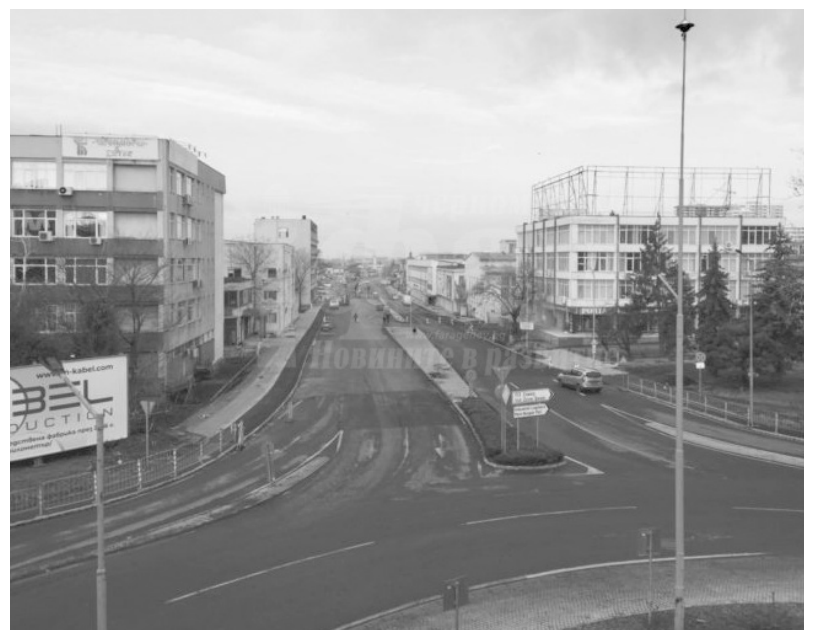
ул. Одрин в началото след ремонт ФОТО: СИЛВИЯ ШАТЪРОВА
