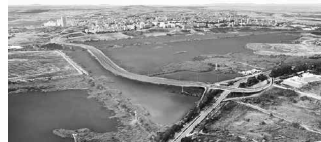
Обходът трябва да премине през езерото. От месеци там върви засипване в едната му част
