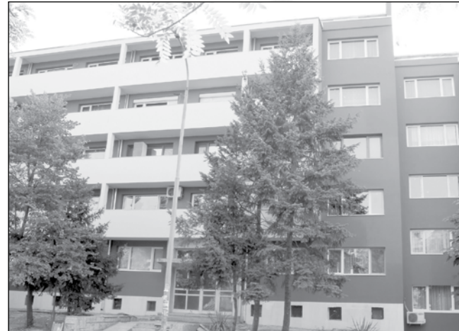
Жилищна сграда в Айтос, санирана по Националната програма за енергийна ефективност на многофамилни жилищни сгради през 2016 г.
