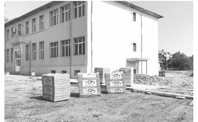
Започна основният ремонт на училището в село Мъзлен ФОТО: НП
