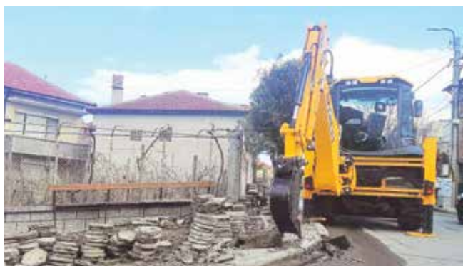
Започна се! Вече са в ход дейностите по проекта за изграждане и реконструкция на улици с прилежащи паркоместа в градския квартал
