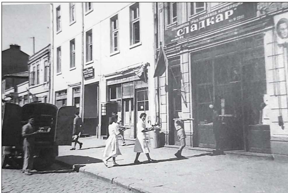
Зареждане на сладкарницата на ул. „Александровска“
