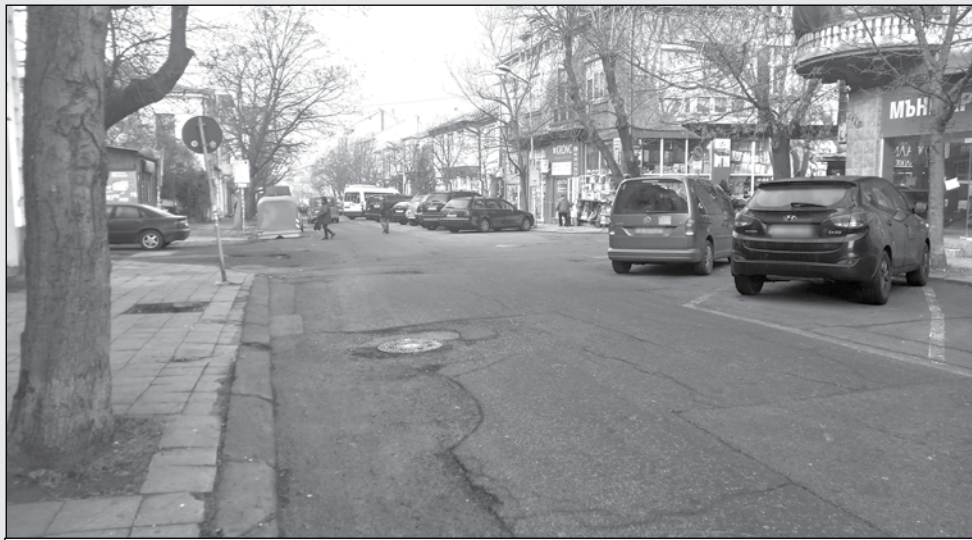
Ремонтът на тази част на ул. „Фердинандова“ ще започне до лятото
