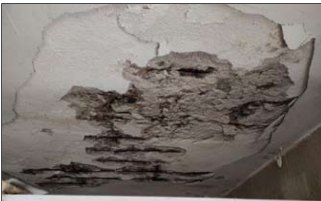
Таванът е с нарушено бетоново покритие и видима армировка
