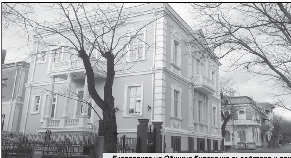
Експертите на Община Бургас ще съдействат и при подаване на проектни предложения по отворените процедури в ИСУН 2020. Приемната на ул. „Княз Александър Батенберг“ №28 е отворена всеки ден от 9:00 до 17:30 часа, включително събота и неделя.
