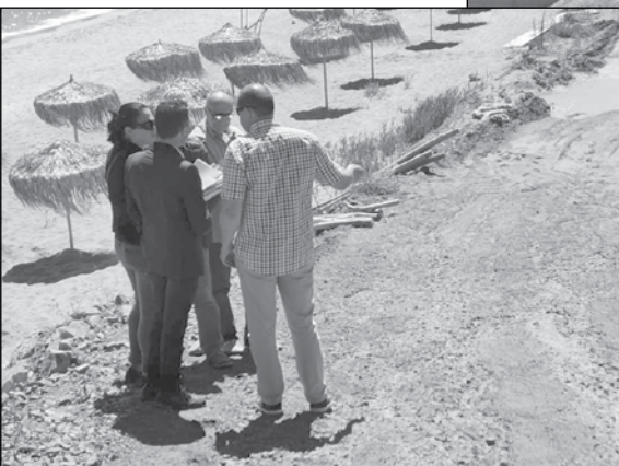
Пред това укрепване ще започне вторият етап - изграждането на хотел
