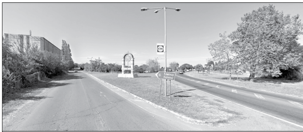
Пътят Каменар-Поморие ще е един от ремонтираните
