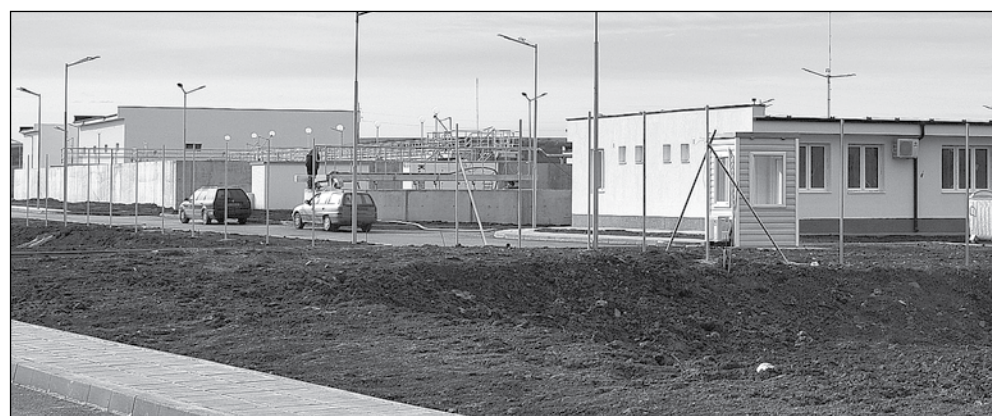
Пречиствателната станция на град Айтос днес
