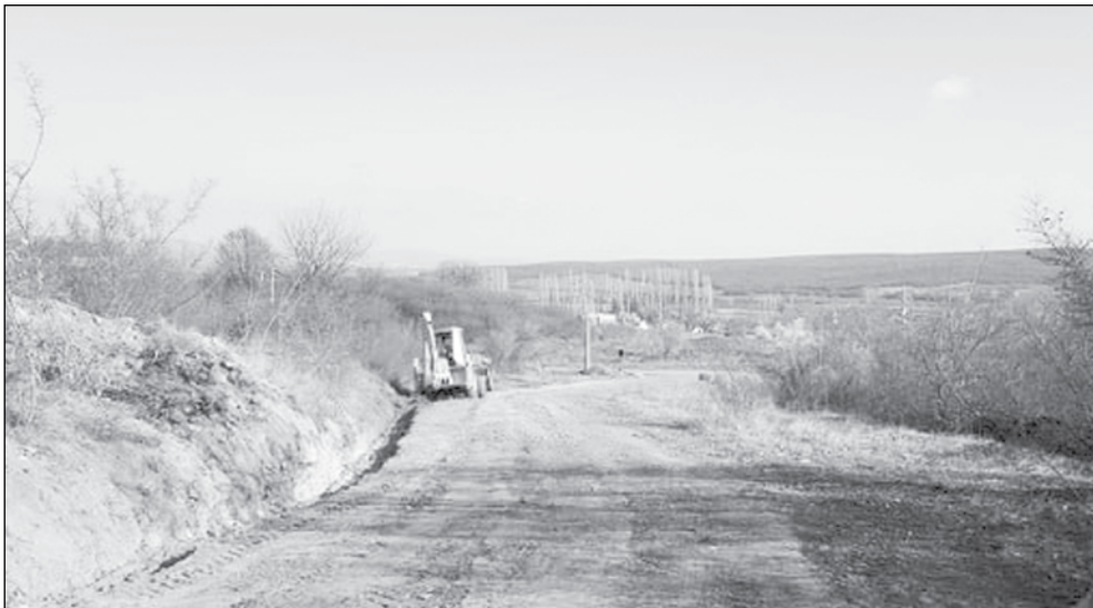
Ремонтът вече е в ход
